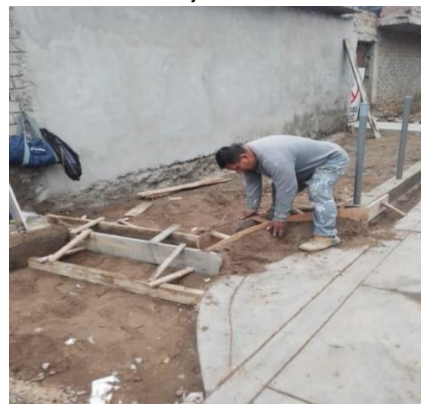
Imagen N°72: Construcción de Sardineles en la Av. Alejandro Tirado
