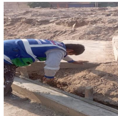
Imagen N°68 Construcción de Sardineles en el parque N°02 de Umamarca.
