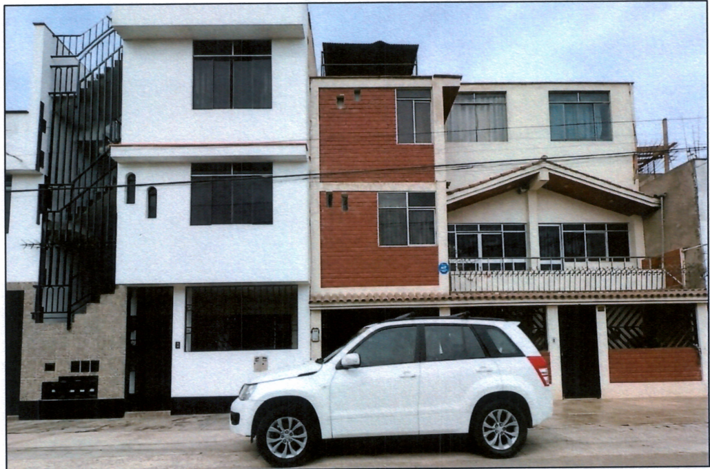
Edificaciones residenciales – Av. Pedro Silva Fuente: Trabajo en campo, 2026.
