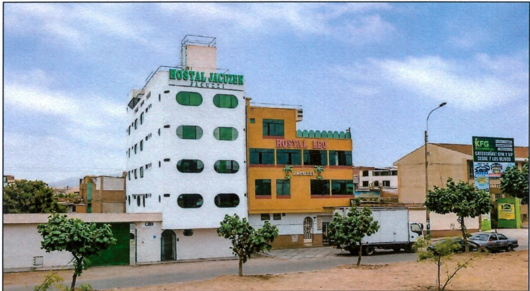
Hospedajes– Carretera Panamericana Sur. Fuente: Trabajo en campo, 2026.
