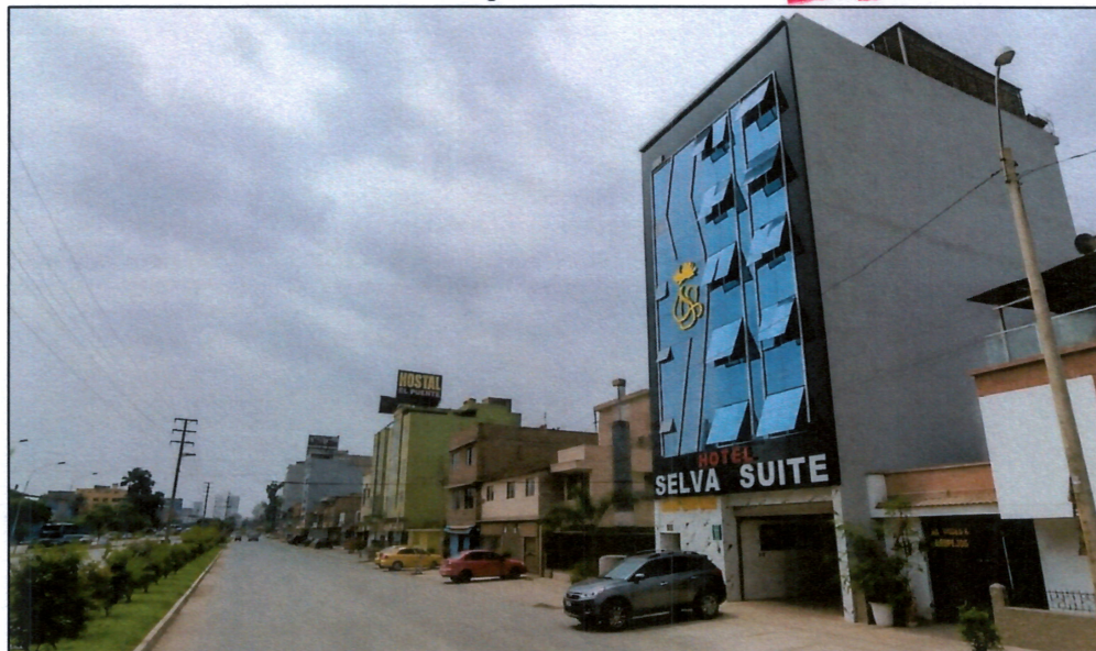
Edificaciones en Avenida Pedro Miotta. Fuente: Trabajo en campo, 2026.
