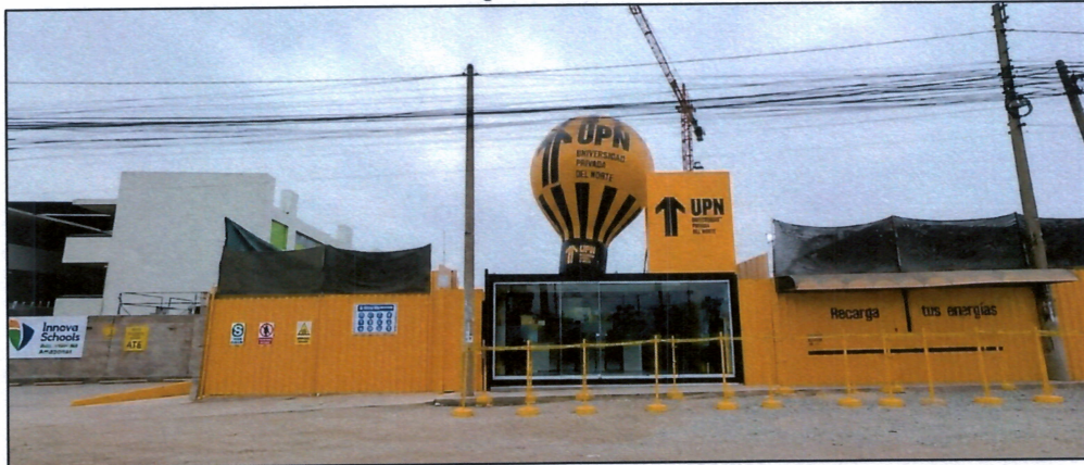
Universidad Privada del Norte (UPN) en construcción – Avenida Pedro Miotta. Fuente: Trabajo en campo, 2026.
